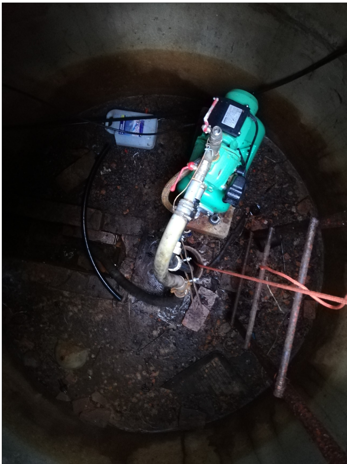
Foto 9 Puurkaevu 5445 suue ja elektriline pump
