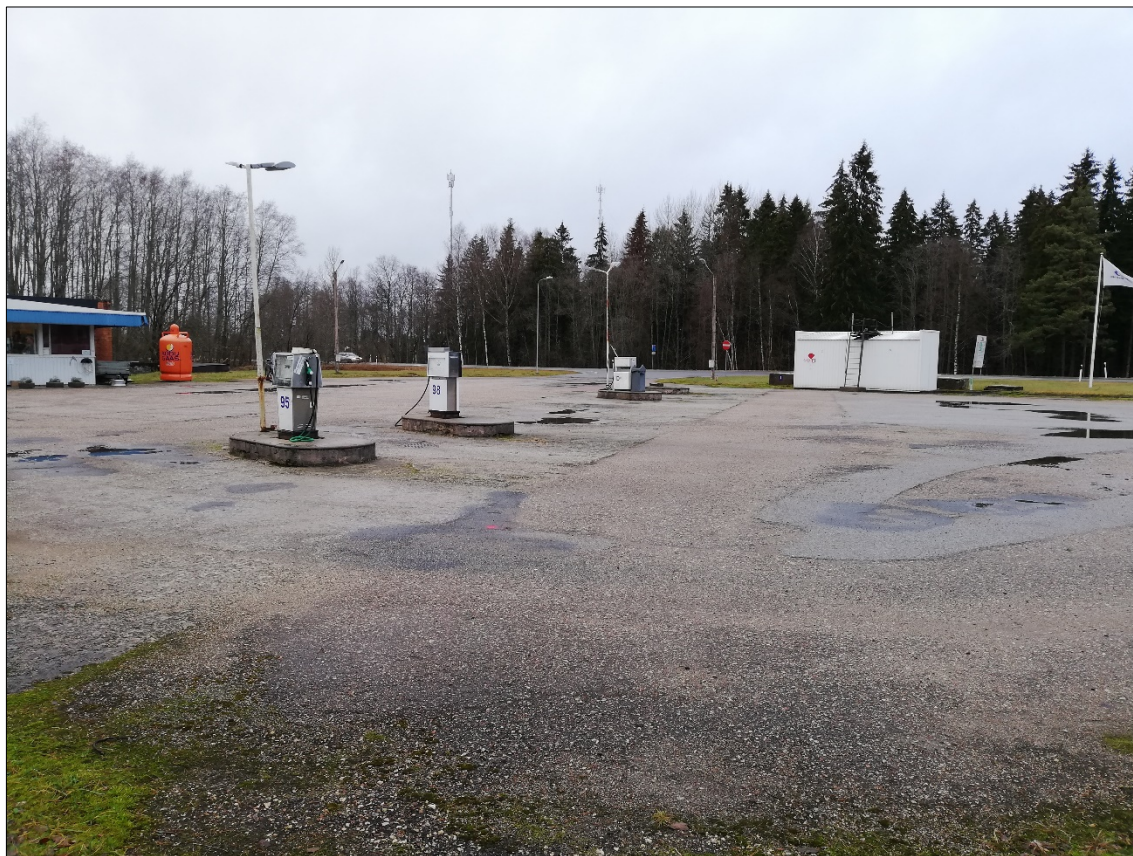
Foto 3 Tankimisplats, murenenud ja praguline asfaltkate
