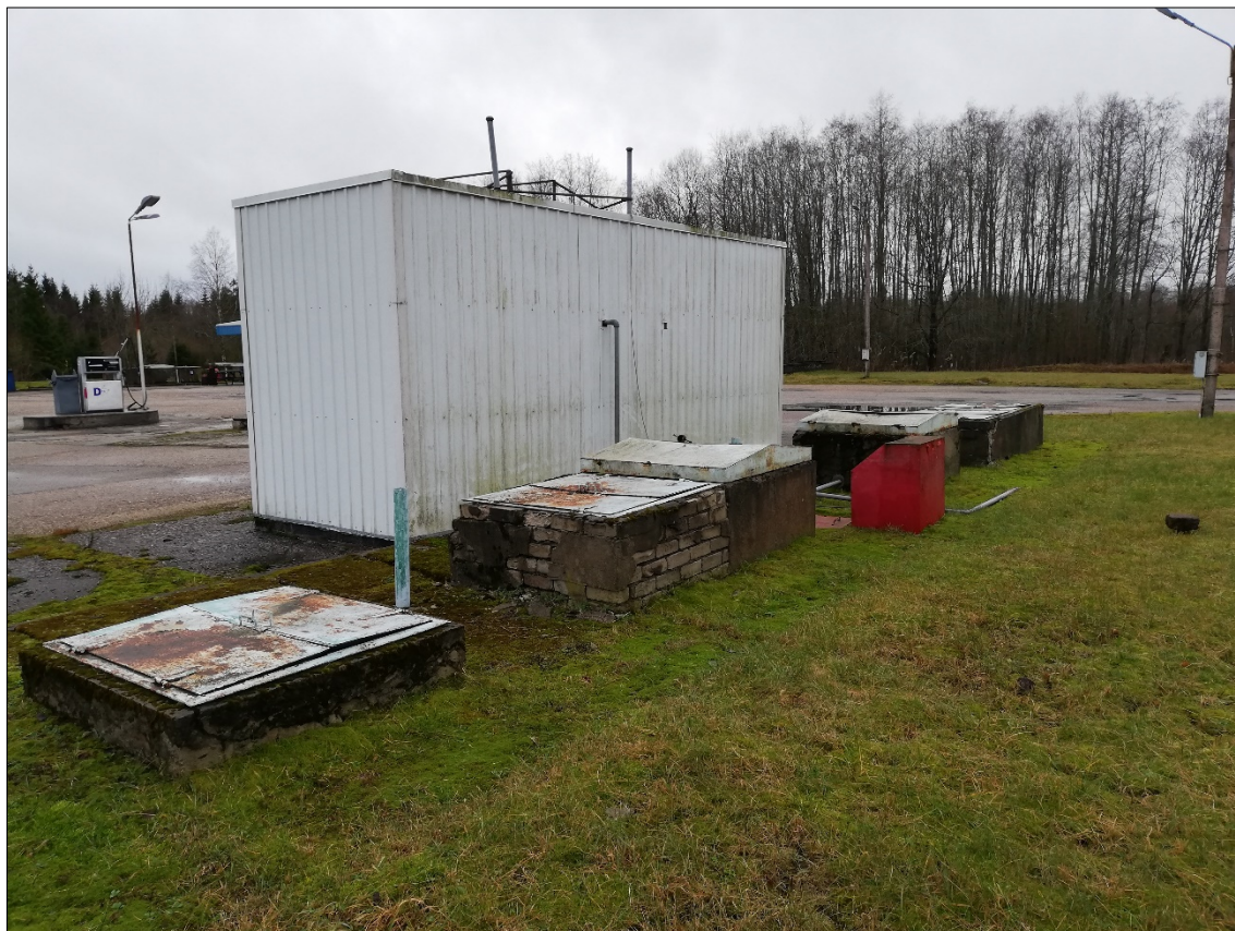
Foto 1 Maa-alused diiselkütuse mahutid ja uus konteinermahuti
